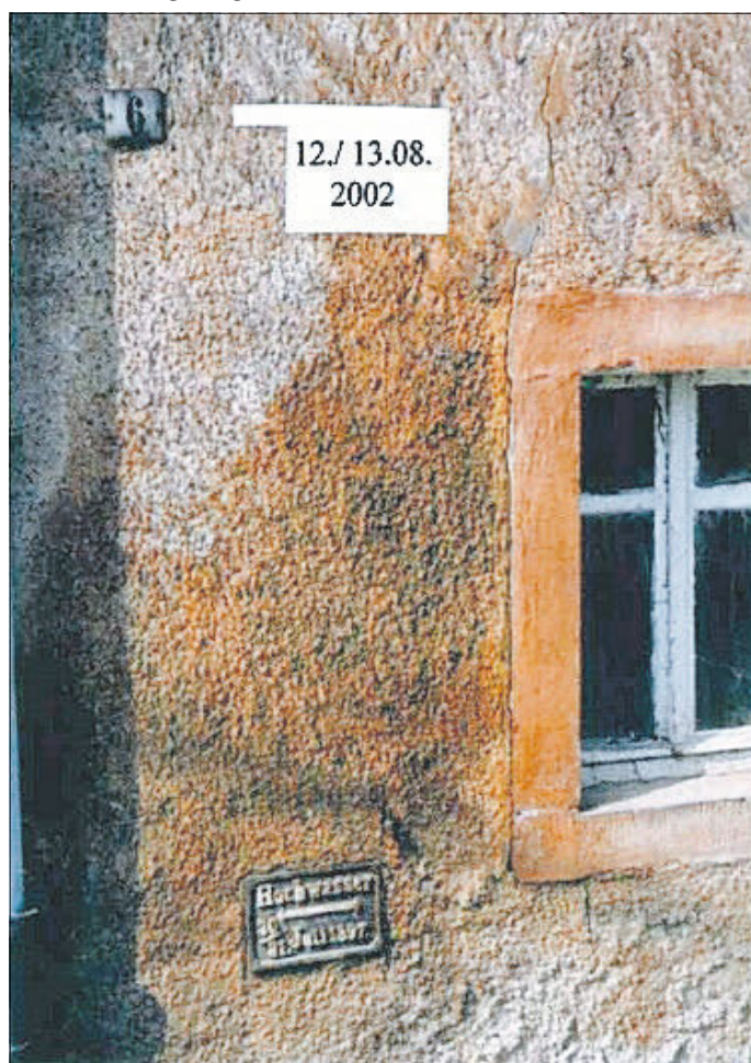
Hochwassermarken von 1897 am Gebäude Freiburger Weg 6 in Halsbrücke und der 153 cm darüber liegende Pegelstand von 2002.
